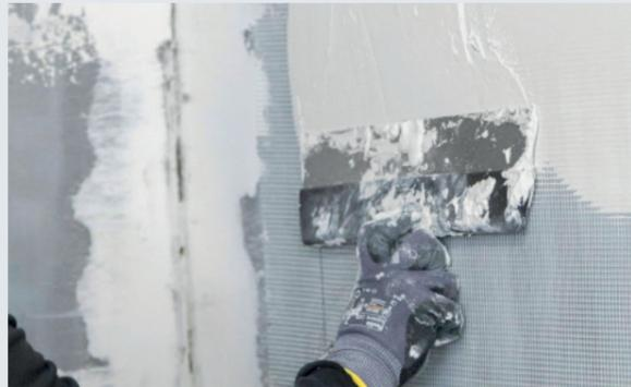
5.5 Skamol Mesh mit einer Überlappung von 10 cm in den nassen Putz drücken.
